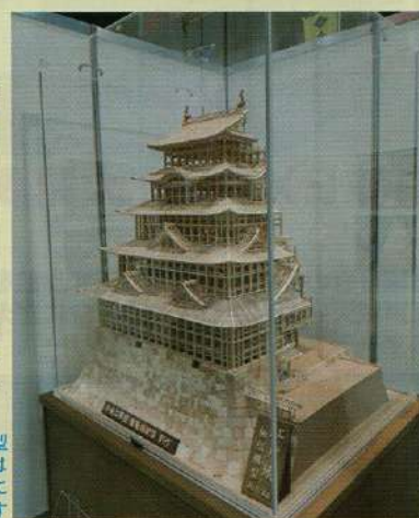
江戸城寛永度天守軸組模型向かって右側の角が欠けているのは模型内部をよく見るためにあえてそうしたためです
