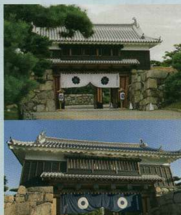
復元された高松城桜御門
